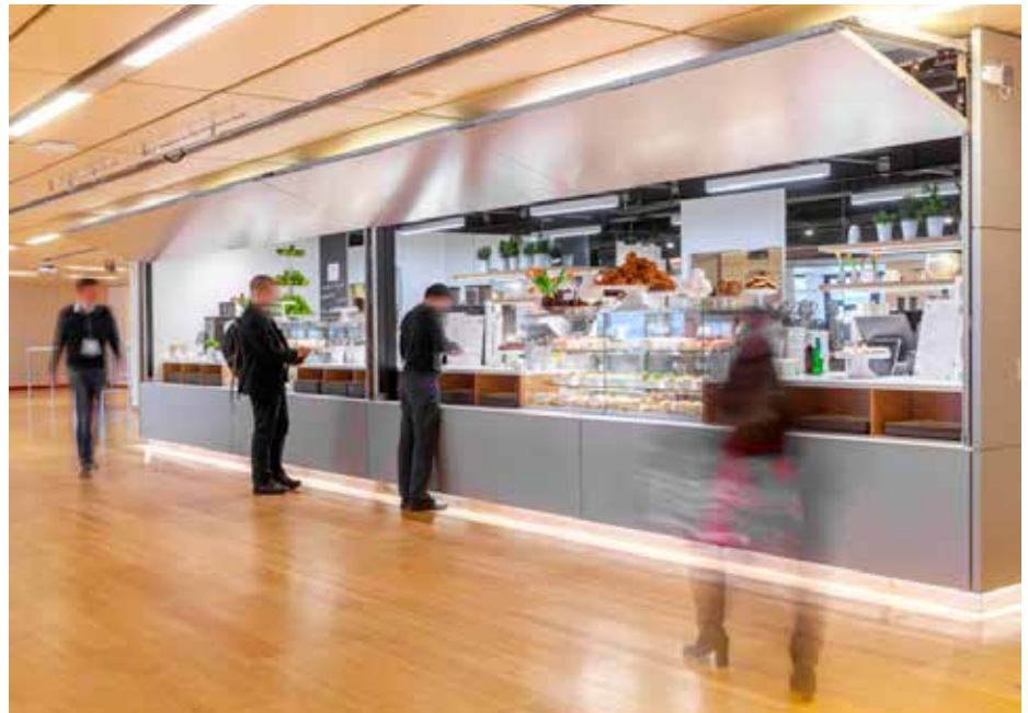
Horizontalfaltläden mit polierter Aluminiumfront als automatisierte mobile Raumteiler im Austria Center, Wien
